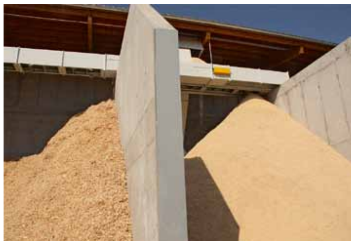
Untertrum-Zwillingsförderer befördern das Hackgut sowie die Sägespäne zum Restholzlager, Verteiler transportieren das Material über den Boxen
